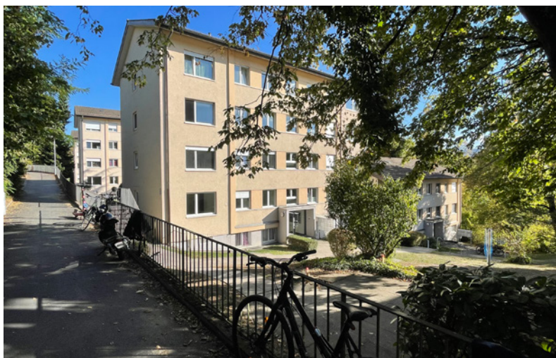
Bei der Siedlung Bombachhalde. (Foto: zvg)
