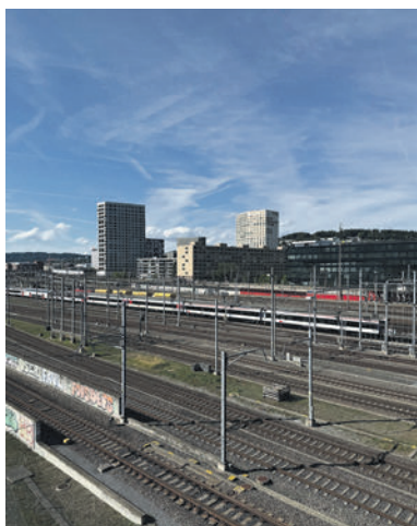
Durch das Bauen in die Höhe wird der Raum am Boden entlastet. (Foto: C. Hobi)
