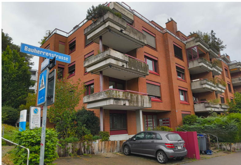
Dieses Gebäude an der Bauherrenstrasse wird total saniert. (Foto: das)
