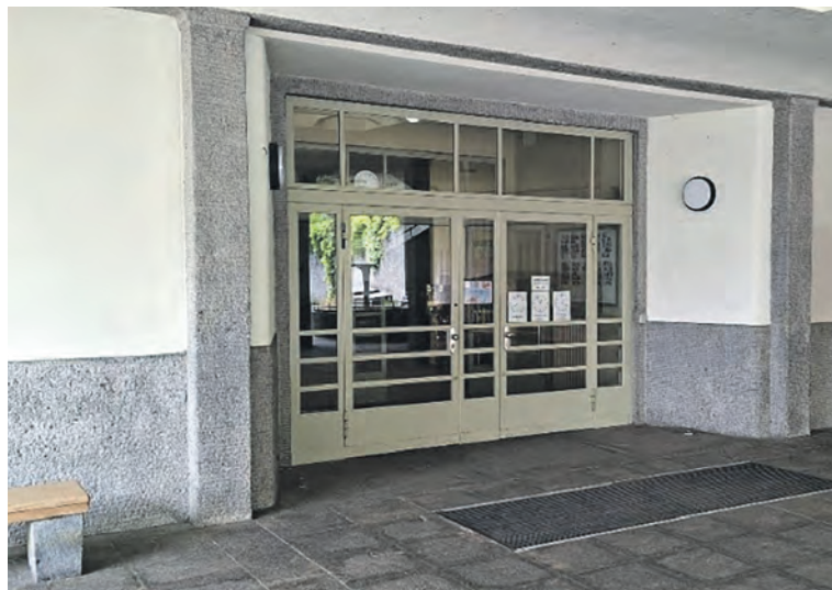
Einfach, funktional, wirksam: Die Türen im Waidhalde-Schulhaus öffneten sich nach dem Umbau 1940 nach aussen. Synode, Schulpflege, Luftschutz, Stadtkommando, Bauamt und Stadtrat setzten dies im Rahmen des Evakuierungsplans um. (Foto: Kurt Gammeter, 2026)
