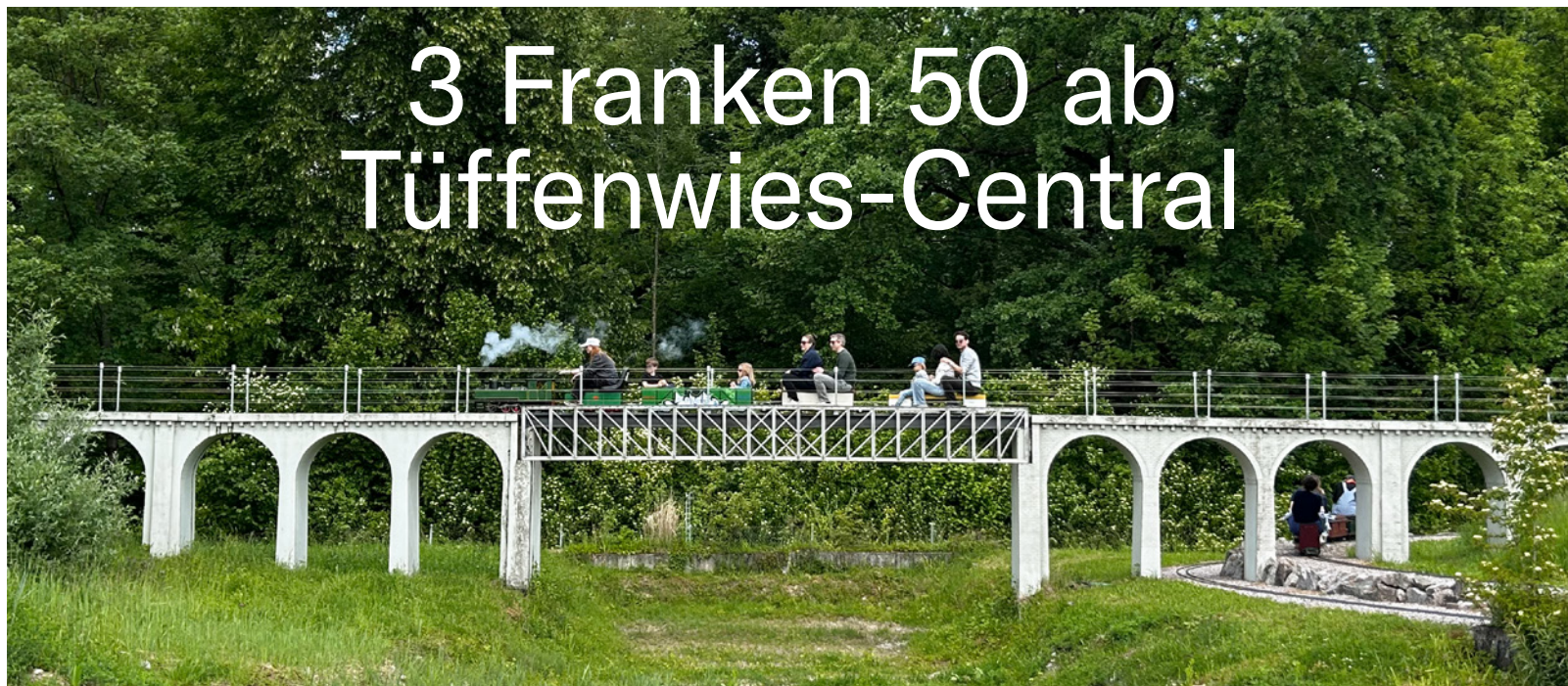
Bei einer Zugfahrt ab Bahnhof Tüffenwies-Central überquert man auch sieben Brücken. (Fotos: dad)
