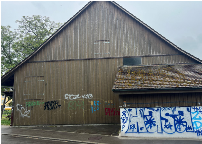
Diese Scheune in Höngg bei der Riedhofstrasse wurde nicht verschont.
