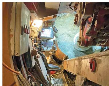
Ein besonderer Arbeitsplatz: Unter der Winzerhalde wird hier der Tunnel für die neuen Kanalrohre gebohrt.
