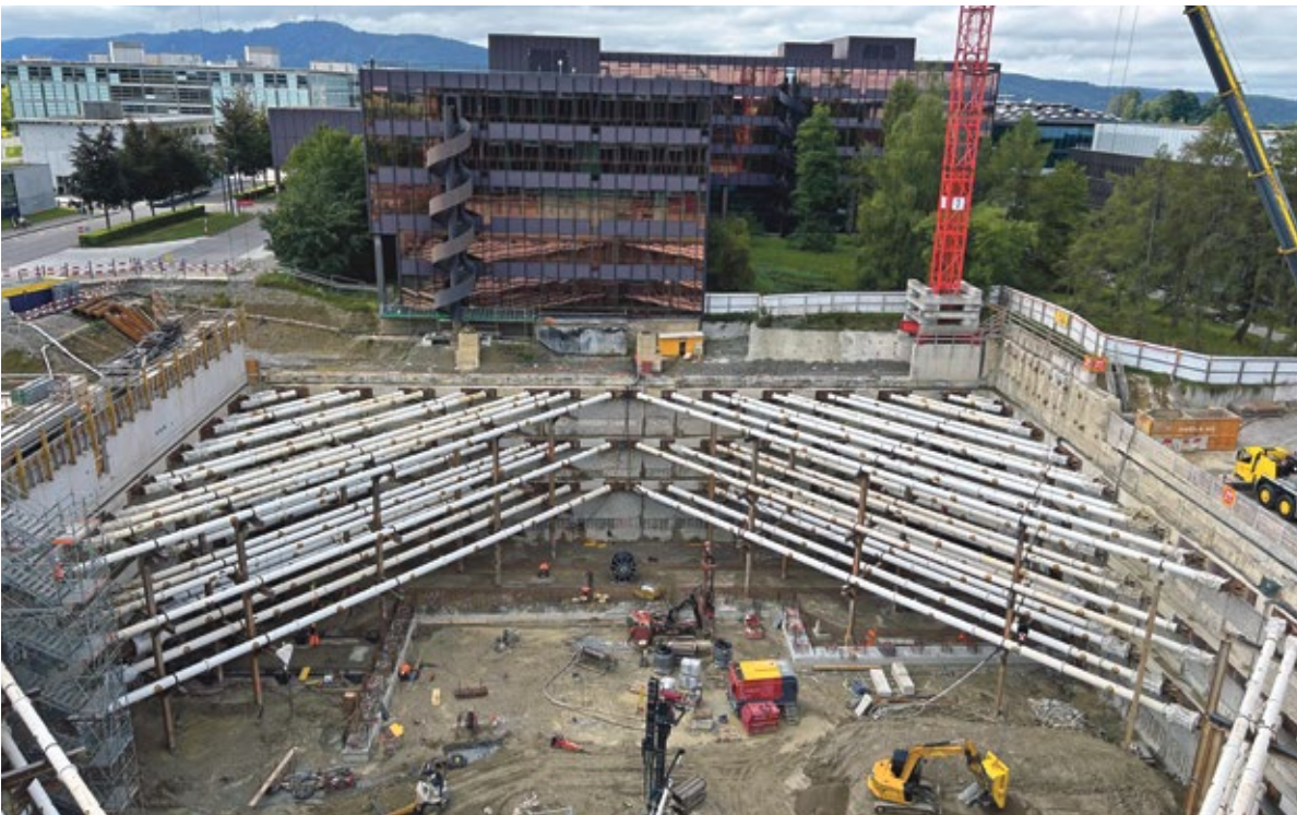
Markant sind die massiven Rohre, die an den Ecken befestigt sind. Es handelt sich um sogenannte Baugrubenspriessungen, die den Druck stabilisieren. (Foto: dad)
