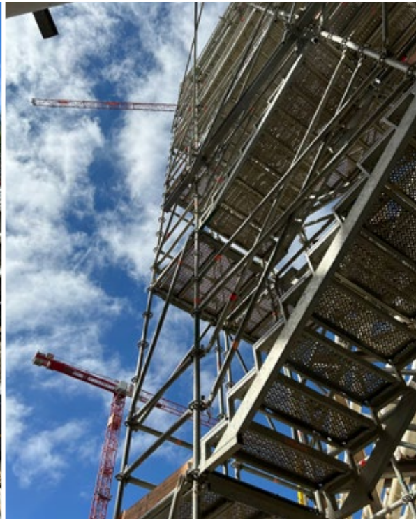
Der Zugang zur Grube erfolgt über ein schmales Treppengerüst.
