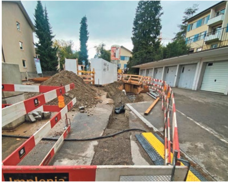
Bauarbeiten an der Winzerhalde: Neben der Fernwärmeleitung werden momentan die Werkleitungen saniert und es wird ein Entlastungskanal gebaut. (Foto: das)
