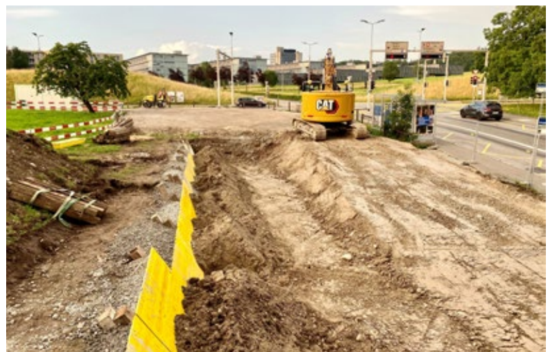
Die Baustelle bei der Haltestelle Hönggerberg. (Foto: pen)
