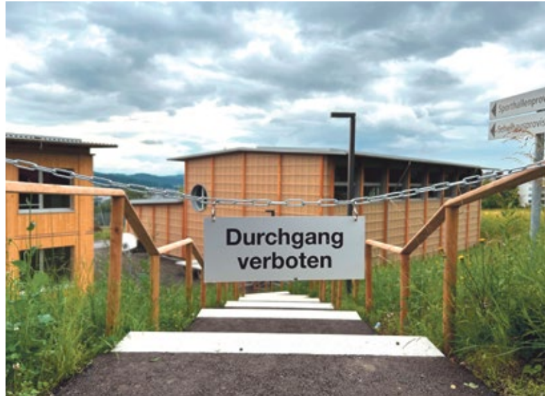
Die Treppe beim Schulhaus Riedhof-Pünten darf nicht genutzt werden. (Foto: dad)
