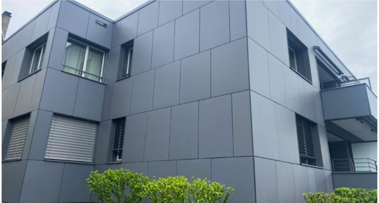
Kühle Fassade mit wärmendem Effekt: die PV-Module erzeugen Strom – auch für die Heizung des Gebäudes. (Foto: das)
