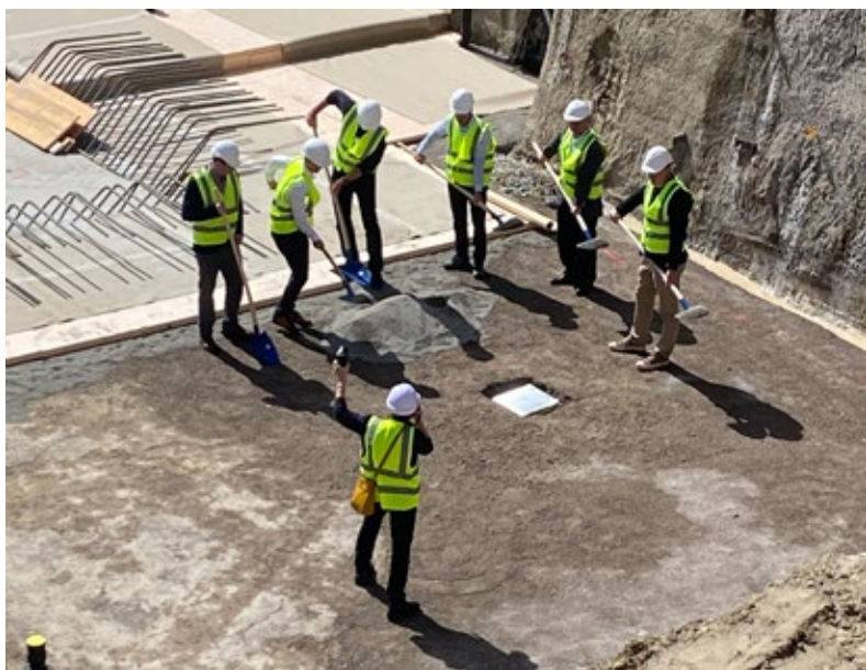
Die Zeitkapsel wird im Boden versenkt. (Foto: das)
