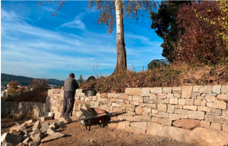
Arbeiten an der sanierten Trockenmauer am Riedhoferrain. (Foto: NVV Höngg)
