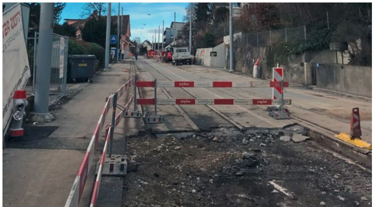
Am Beginn der Limmattalstrasse auf der Baustelle. (Foto: dad)
