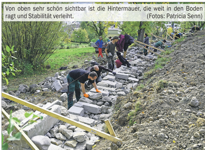
Die obere Trockenmauer haben Helfer*innen und Mitglieder des NVV gebaut.
