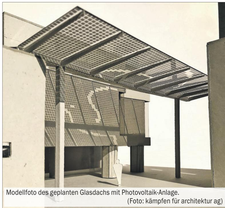
Modellfoto des geplanten Glasdachs mit Photovoltaik-Anlage.
