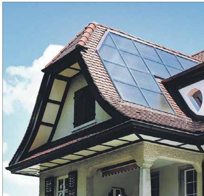
Thermische Solaranlage (12,7m<sup>2</sup>) in der Region Luzern: optimal in die Dachform integriert. (zvg)
