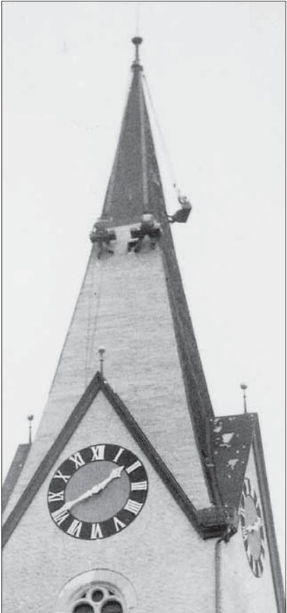
Renovation der West- und Südseite des Kirchturms, 1954: Die Arbeiter hängen am Flaschenzug. (zvg)
