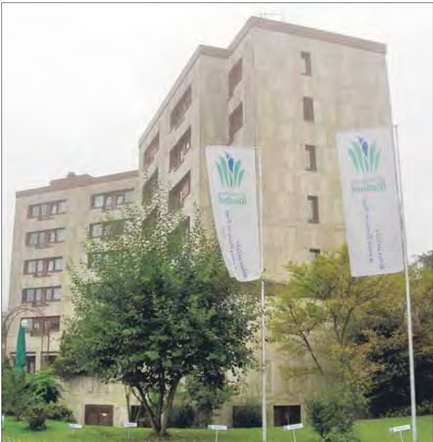
Steht auf warmem Boden: das Alterswohnheim Riedhof.
