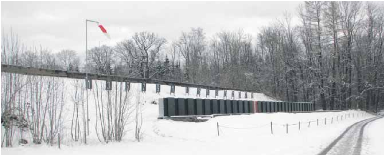
Frisch montiert: die auffallenden neuen Kugelfangsysteme bei der Schiessanlage Hönnggerberg.
