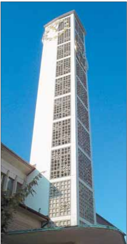
Der 38 Meter hohe Kirchturm in Altstetten (Architekt Werner Max Moser, 1938–1941) wurde 2004 restauriert.
