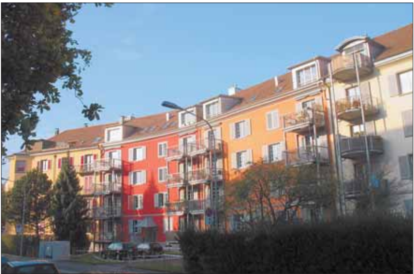
Die Mehrfamilienhäuser Haldenstrasse 174 und 176 in Wiedikon waren vor dem Umbau 2006/07 ohne Zentralheizung und ohne Dachausbau.
