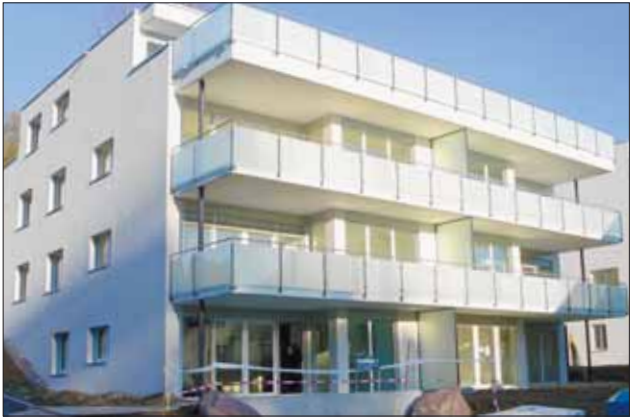
In den beiden Neubauten (2003) an der Riedhofstrasse in Höngg entstanden 14 Eigentumswohnungen.
