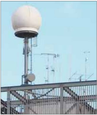
Physikgebäude/Wetterradar ETH Hönggerberg.
