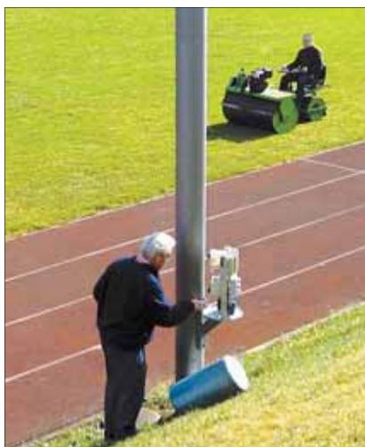
Elektrokontrolle und Platzwalzen.
