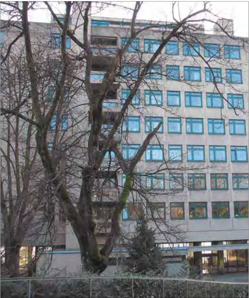
Das Pflegezentrum Bombach wird während zwei Jahren saniert. Foto: Sarah Sidler
