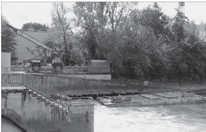
Mit schweren Maschinen werden die Ufermauern repariert.
