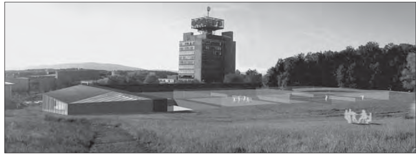
Ansicht von Osten her auf die Aussenplätze und die Sporthalle (links).
