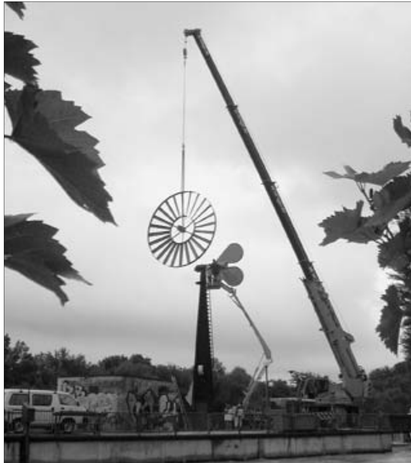
Ein Kran hievt das Windrad an seinen angestammten Platz. (bgr)
