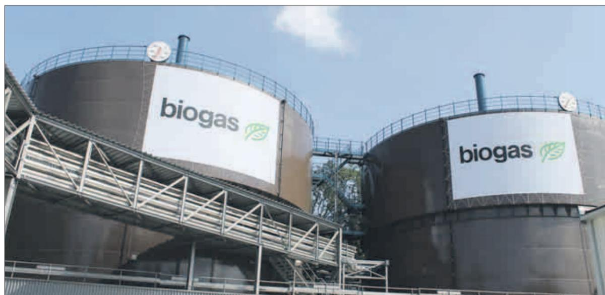
In diesen Tanks auf dem Gelände des Klärwerk Werdhölzli wird das Biogas gelagert.
