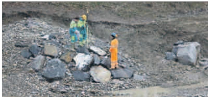
Hier wird gerade eine sogenannte «Bühne» gebaut. Sie dient bei Hochwasser zur Steuerung der Strömung.
