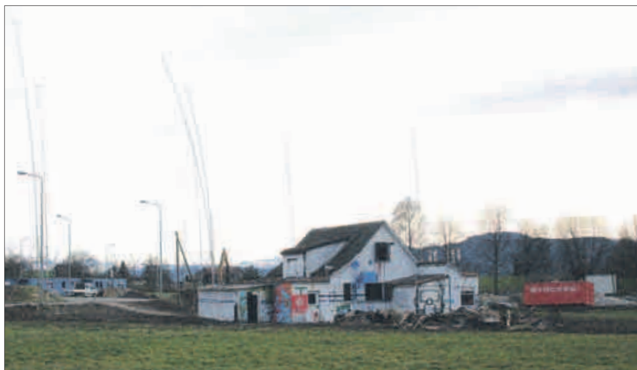
Das Senderhäuschen kurz vor dem Abbruch.
