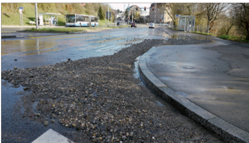
Das Wasser versiegt, zurück blieb, was an Strassenunterbau ausgeschwemmt wurde. (Fotos: Fredy Haffner)
