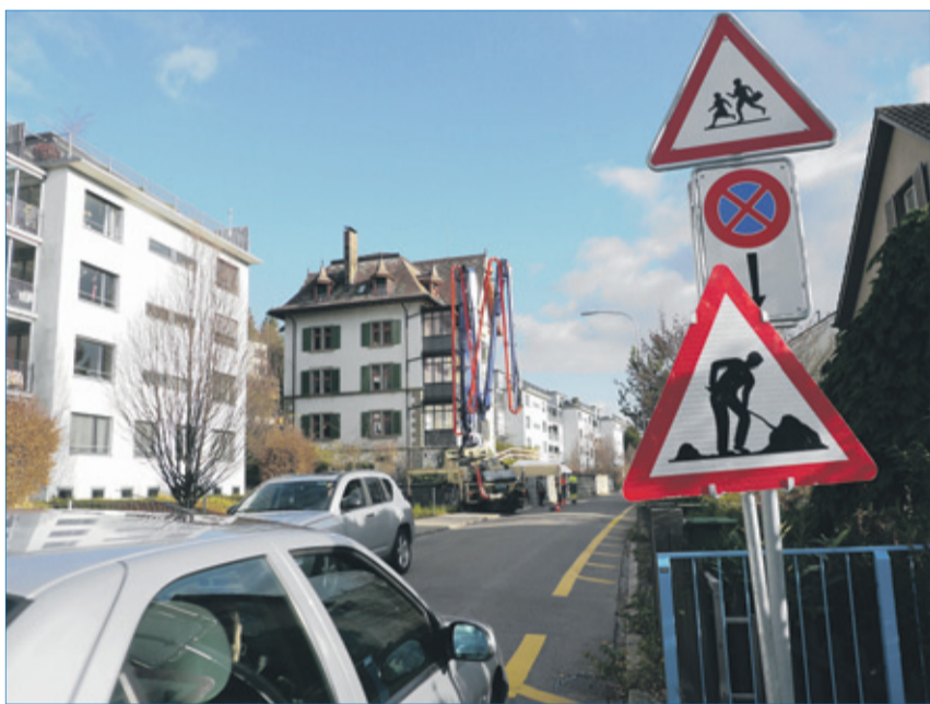
Nicht erst seit den Bauarbeiten ein Engpass, sondern schon seit unzähligen Jahren eine risikoreiche Stelle, nicht nur für Schulkinder. (Fotos: Fredy Haffner)
