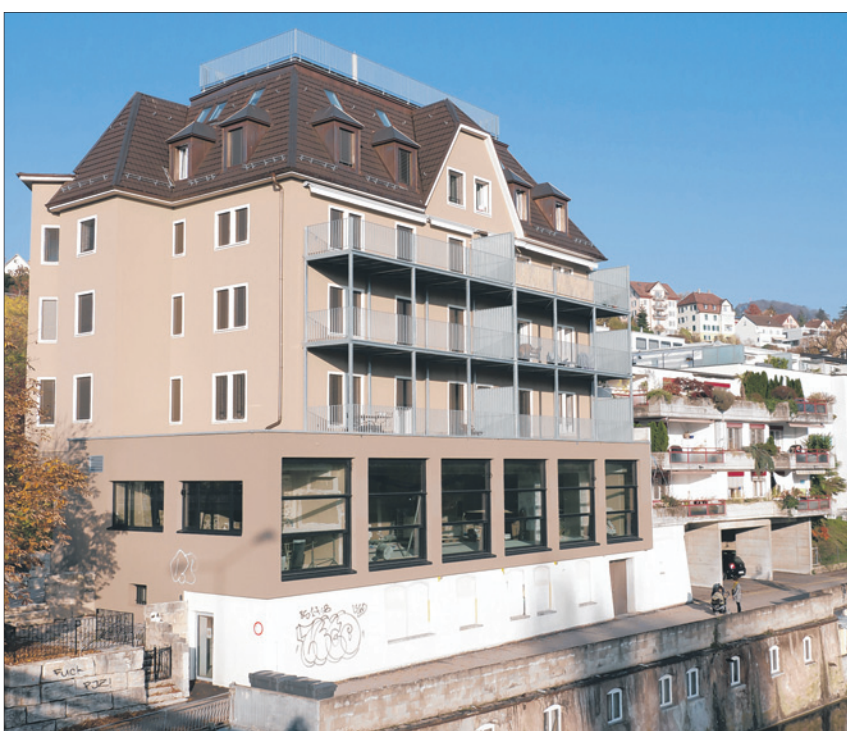
Sollte gemäss Besitzer im Frühling 2016 auch wieder öffnen: Der «Limmathof» bei der Europabrücke.
