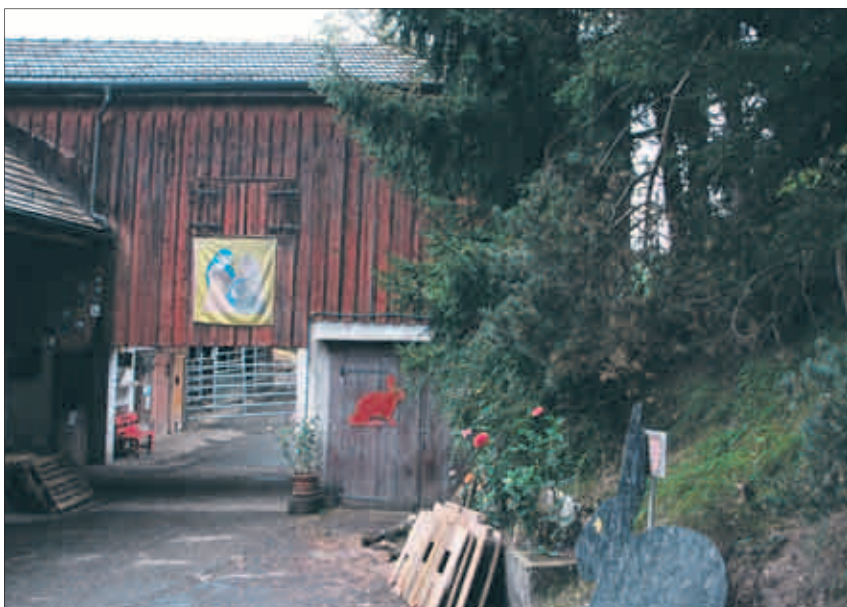
So sieht der QuarTierhof Höngg zurzeit aus. Er wird voraussichtlich im Jahr 2016 umgebaut.
