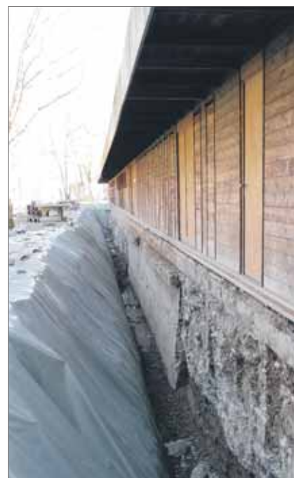
Vorübergehend kein Zugang zu den Umkleidekabinen des ehemaligen Waidbades.
