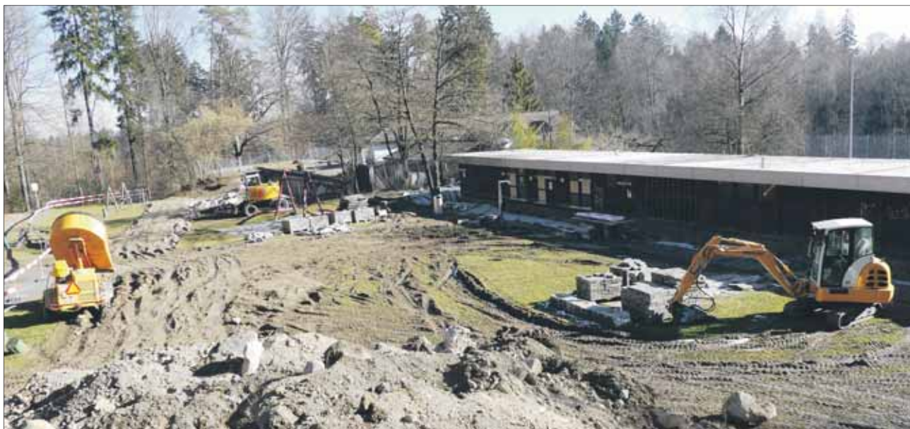
Eine einzige Baustelle: Wo einst das Waidbad war, müssen heute die Nachbarliegenschaften gegen Wassereindringen abgedichtet werden. (Fotos: Freddy Haffner)
