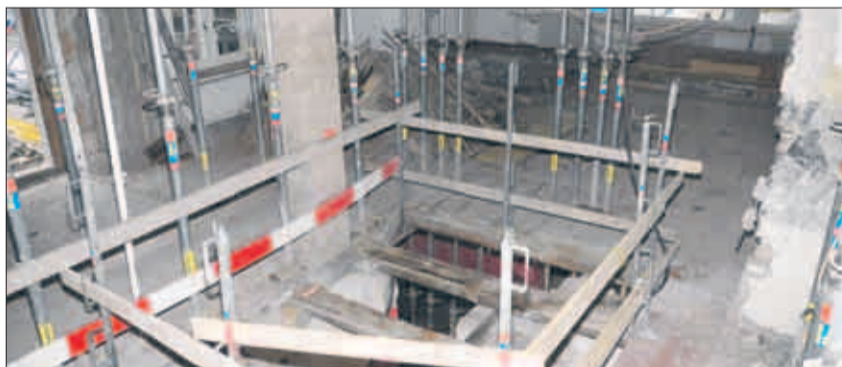
Derzeit im «Sonnegg»: alle Zwischenwände entfernt und freie Sicht durch die Böden. (Fotos: Freddy Häffner)
