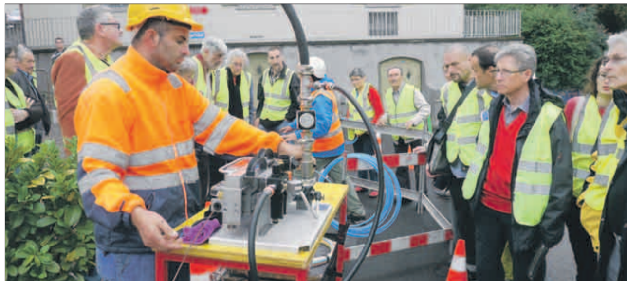
Die Glasfaserkabel werden in die Rohre eingeblasen, nicht eingezogen.
