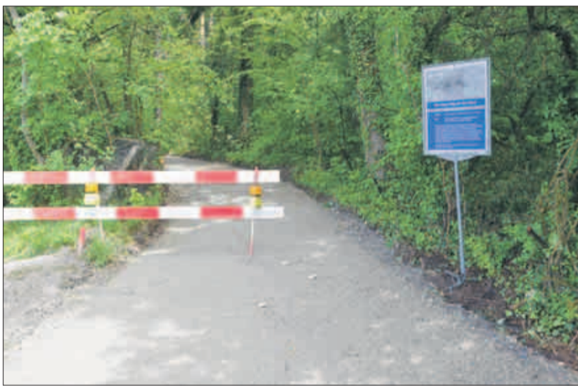
Die neue Waldstrasse, welche anstelle des Trampelpfades benutzt werden soll. (Foto: Dora Hardegger)
