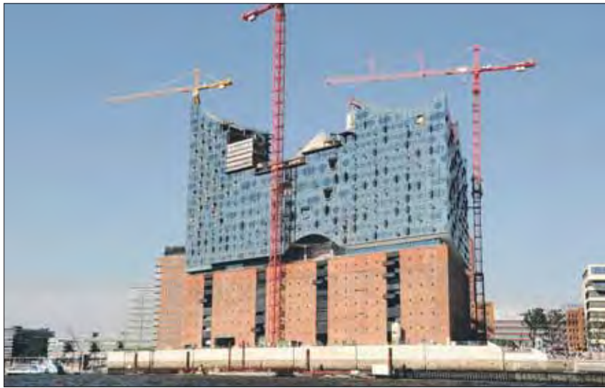
Die Elb-Philharmonie ist ein imposanter Bau.
