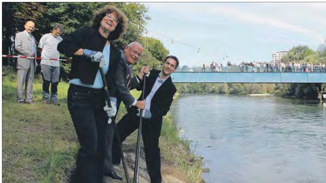
Ruth Genner, Markus Kägi und Thomas Vellacott beim Spatenstich an der Limmat: Brocken der Uferverbauung wurden mit vereinten Kräften ins Wasser gestossen (von links). (Foto: Malini Gloor)
