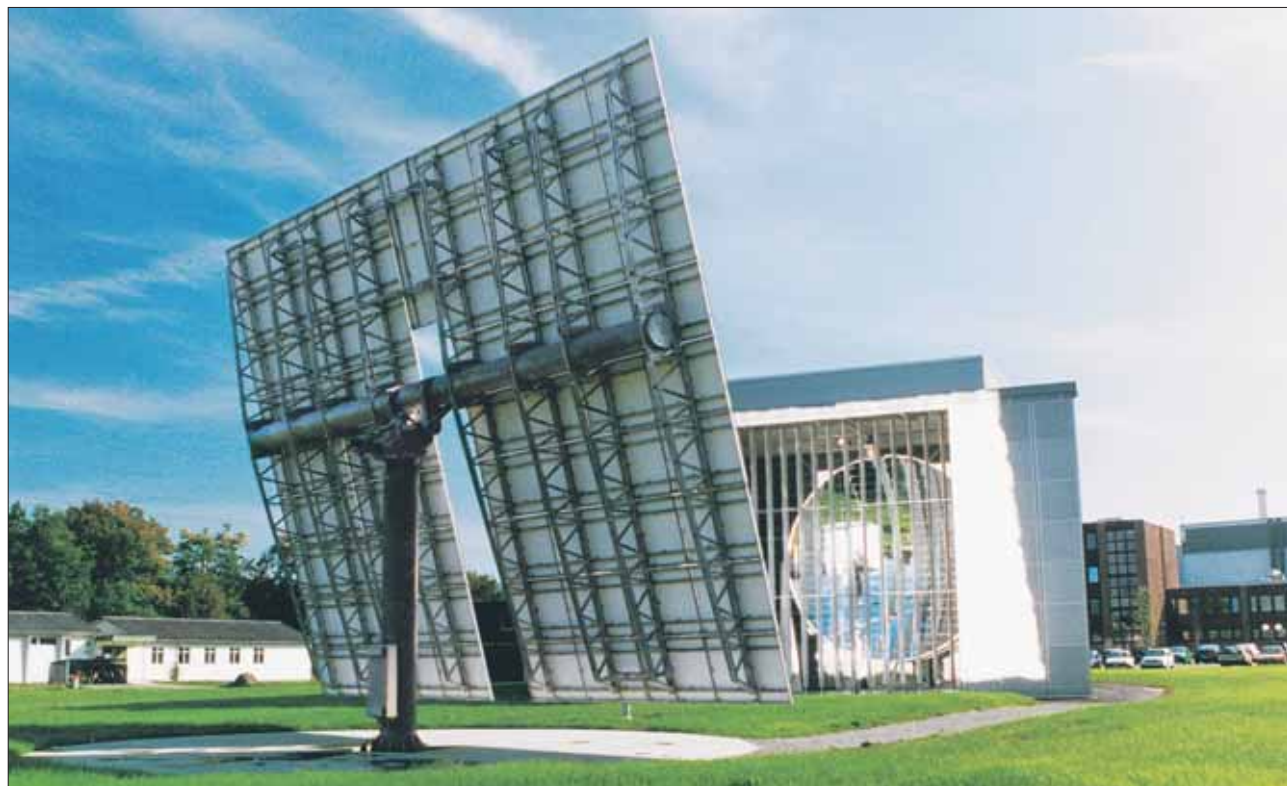
Der Solarkonzentrator mit 120 Quadratmeter grossen Spiegeln.
