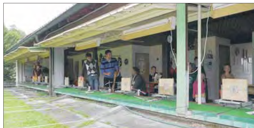
Das Schützenhaus von einem Standort fotografiert, an dem man besser nicht stehen sollte.
