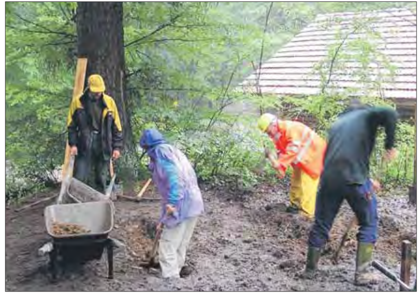
Im schweren Grund werden die Gräben für die Fundamente der Bänke und Tische ausgehoben. (Foto: Hans-Ruedi Frehner)
