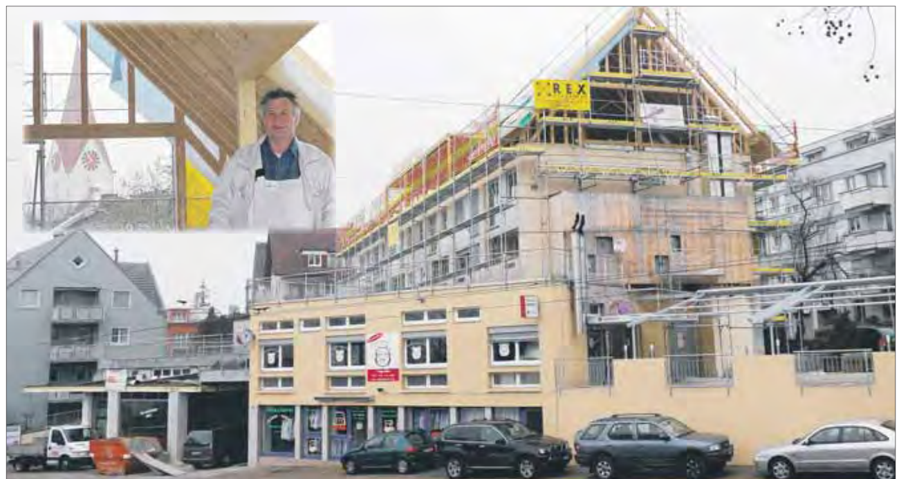
René Frigerio im «Gwändli» unter dem neuen Dachstuhl des «Limmatbergs»: «Diese Aussicht musste man doch nutzen.»
