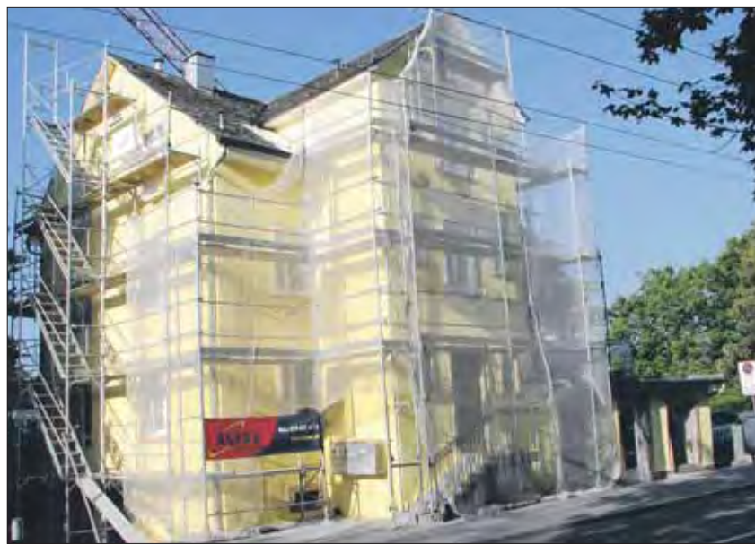
Hatte eine Fassadenrenovation nötig: Das Haus an der Regensdorferstrasse 19.
