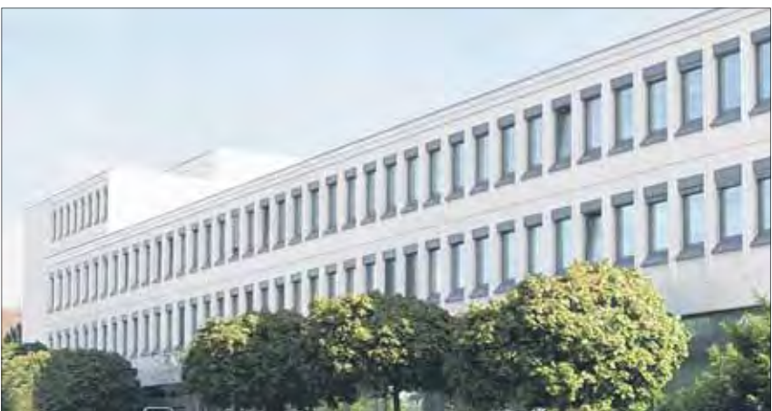
Klare Gebäudekonturen mit repetitiver Anordnung der Fenster: das Airport Business Center Glattbrugg. (zvg)
