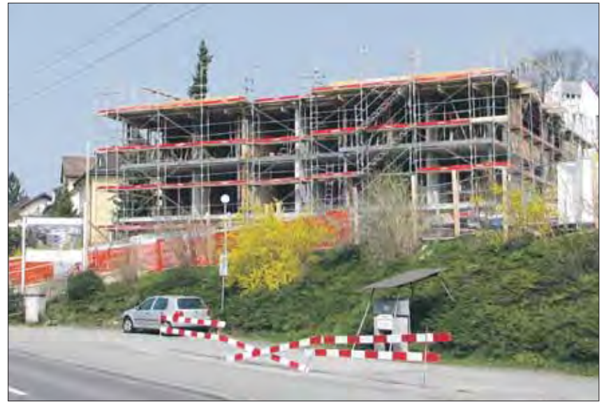
... und der entstehende Neubau an der selben Stelle.
