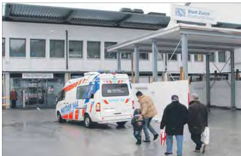
Haupteingang Waidspital, zurzeit noch eine Baustelle. Der Eingang der Notfallstation befindet sich, hier versteckt, am rechten Bildrand. Fotos: Freddy Häffner
