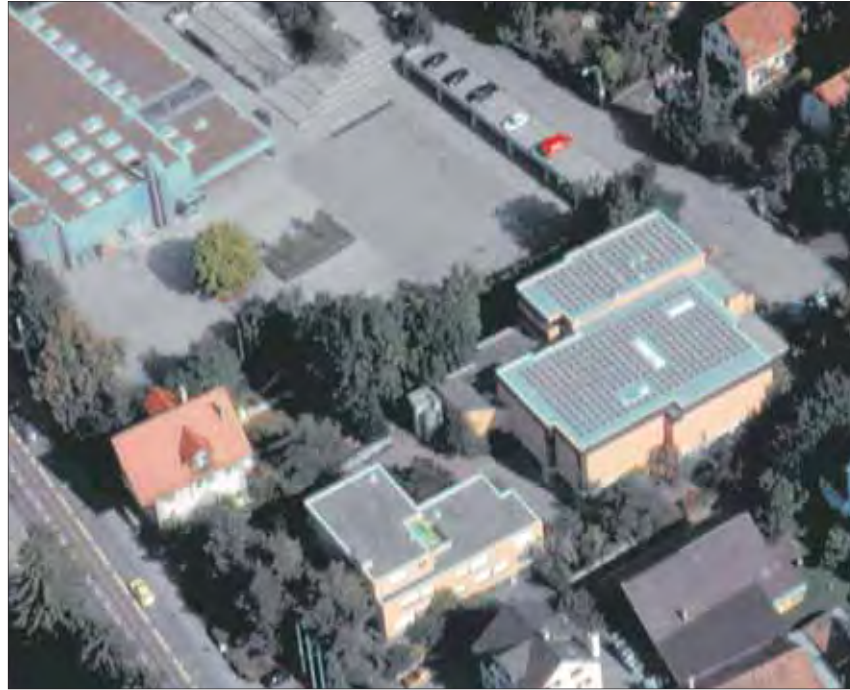
Solarzellen auf dem Dach des Pfarreizentrums.
