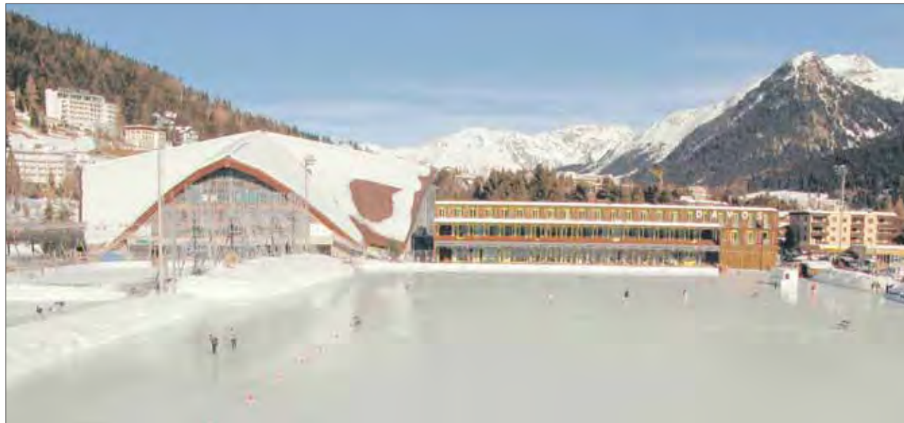
Klimafreundliches Eislaufen in Davos: Mit der Abwärme der offenen Kunsteisbahn wird neu das Hallenbad geheizt. (ch-fo/Gemeinde Davos)
