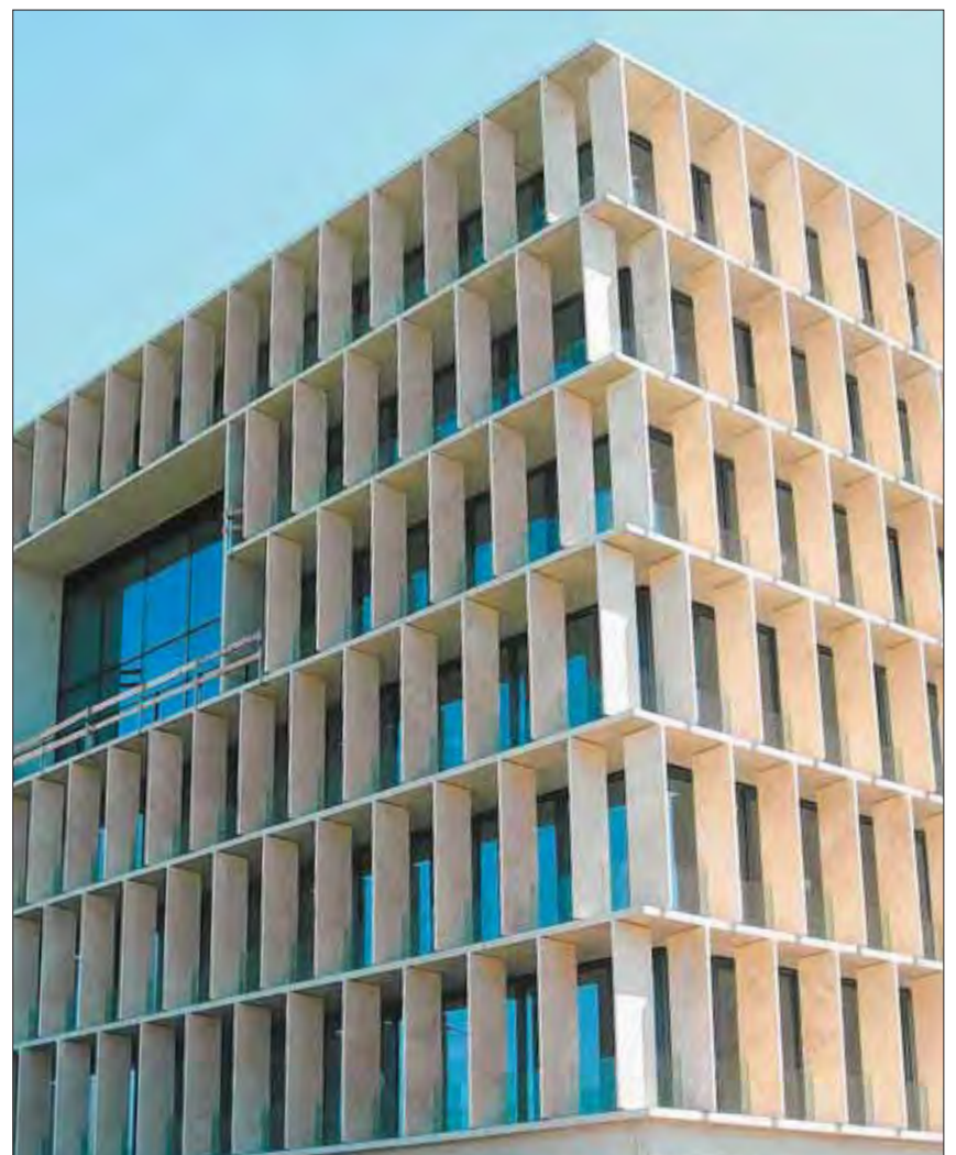
Die Kombination aus Waben und Glas prägt das Gebäude. (mwe)
