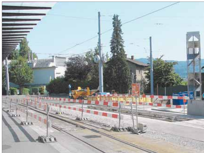
Die Bauarbeiten im Frankental dauern noch rund eine Woche. Foto: Sarah Sidler
