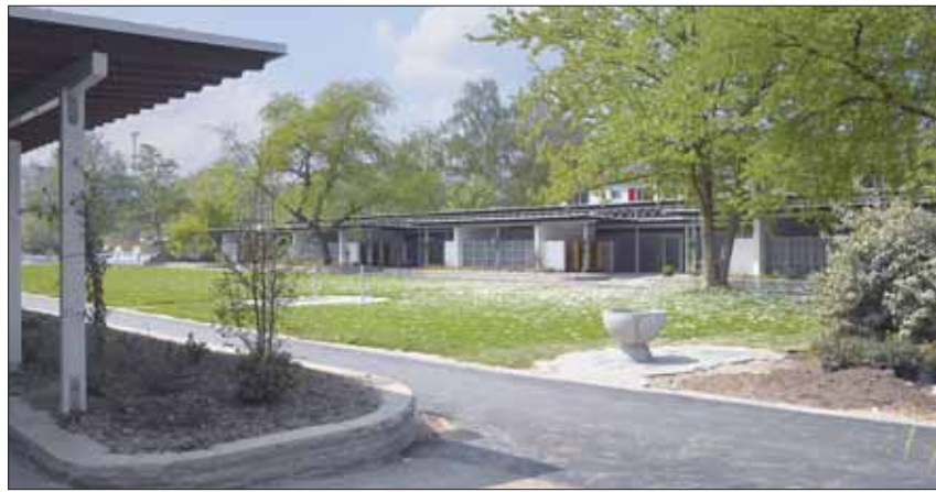
Der Gartenhof bildet den Eingangsbereich des Freibades. (zvg)
