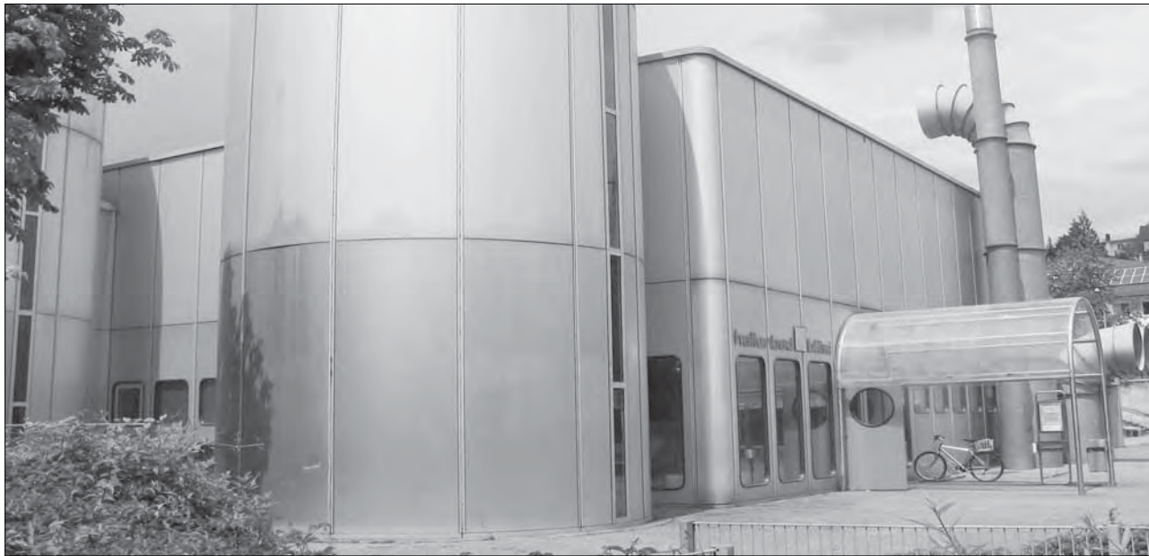
Das Hallenbad Bläsi wird in den nächsten zwei Sommerferien instand gesetzt.
